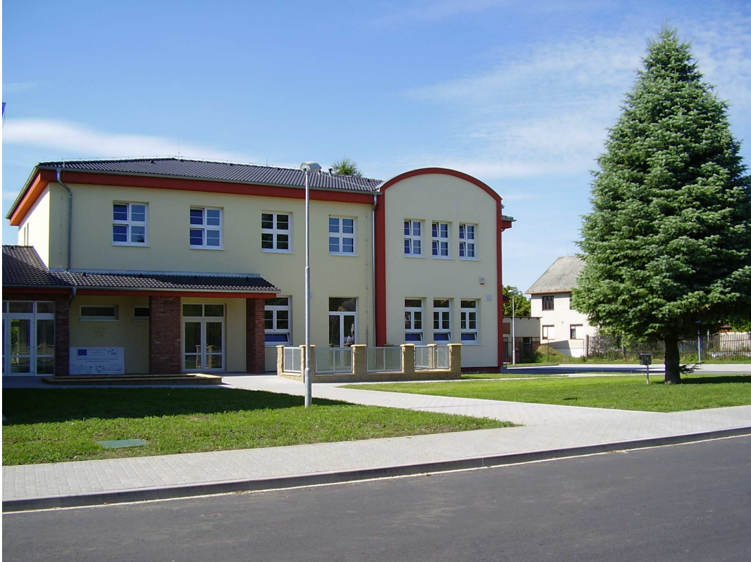
Nová administrativní budova
