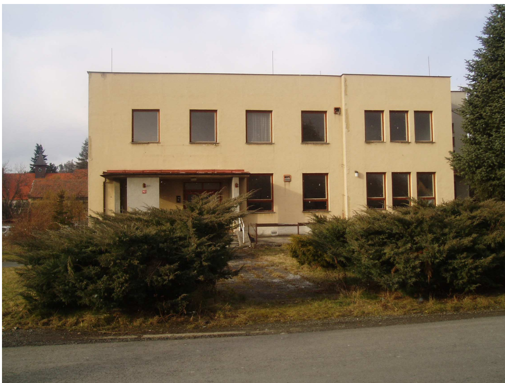
Stávající objekt s pozemkem před jeho revitalizací
